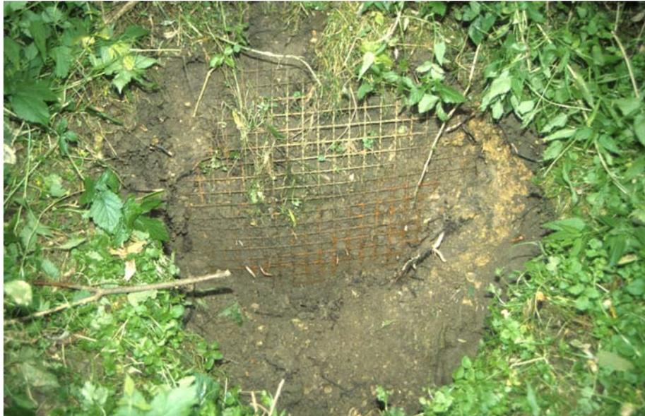
Ufersicherung mit eingegrabenen Wellengittern an der Kleinen Donau.
