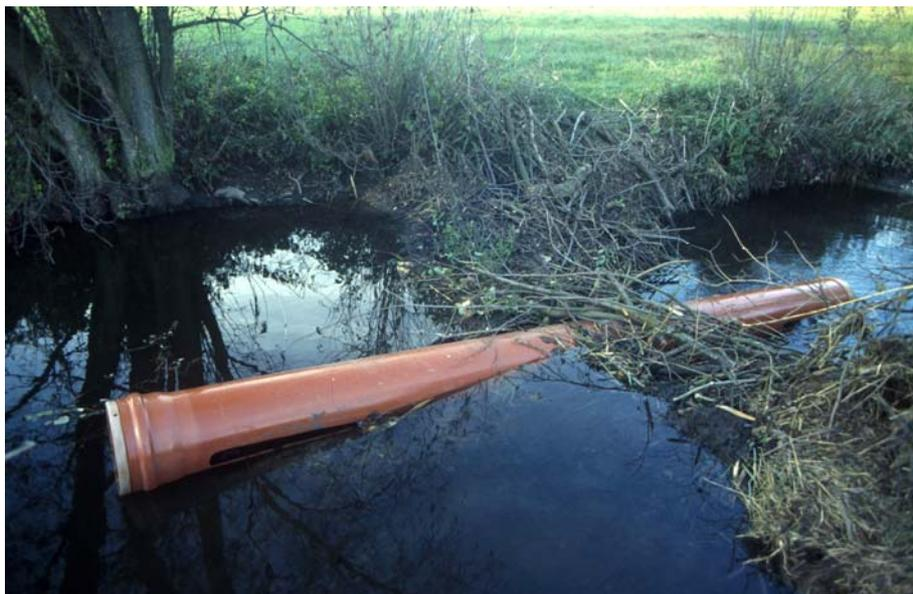
Drainage eines Biberdammes zur Absenkung des Wasserspiegels
