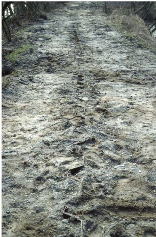
Ufersicherung mit Spundwänden
