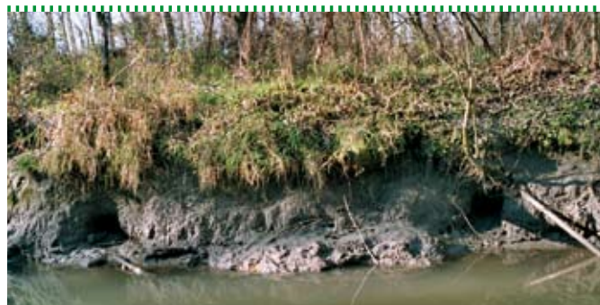
Bei Niederwasser werden Röhren, die in den Wohnkessel eines Erdbaues führen, sichtbar
